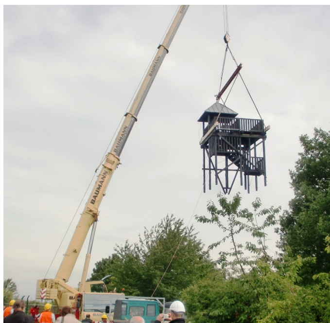
Der Turm wird umgesetzt
