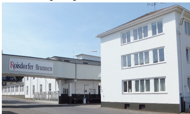
Betriebsgebäude des Roisdorfer Brunnens
