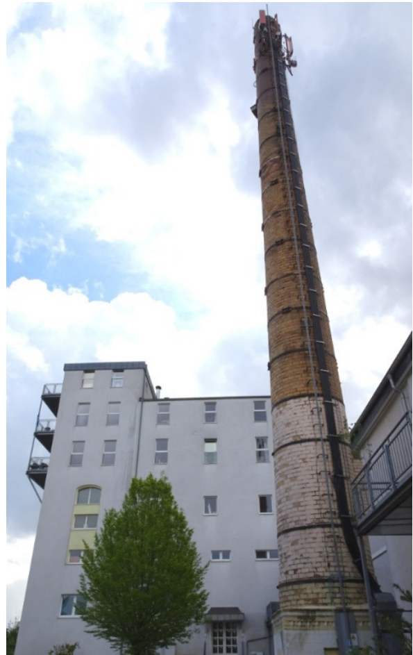
Turm und Schornstein der ehemaligen Germania Brauerei.
