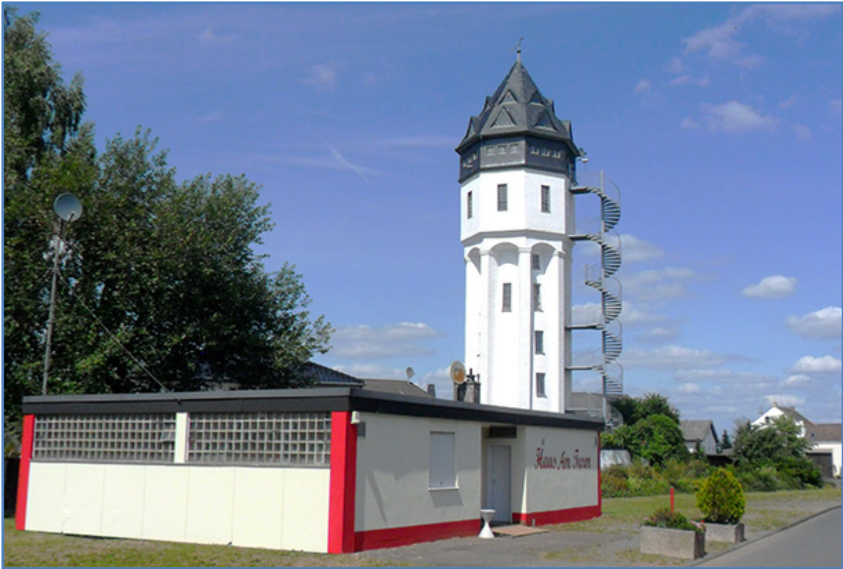
Rösberger Wasserturm und Dorfgemeinschaftshaus.
